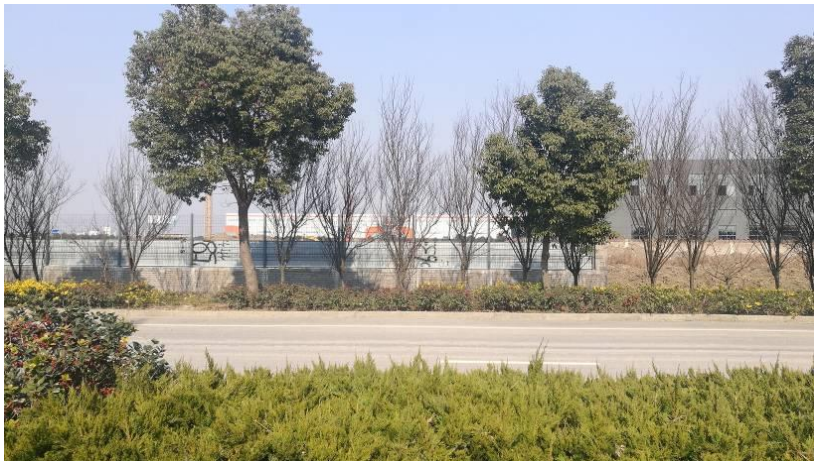
西侧为格兰德机械在建厂房
